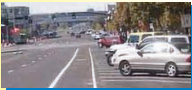
Foto 9 - Arlington (Texas). L'inclinazione 'retroversa' degli stalli è qui accompagnata da una fascia ciclabile/fascia di manovra della sosta che rende ancora più sicura la circolazione dei ciclisti.
