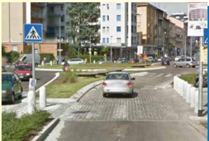
6- Milano, piazza Gambara. L'attraversamento rialzato, realizzato in massetti di porfido posati 'a correre' in senso longitudinale, provoca un pericoloso 'effetto rotaia'.
